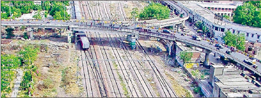
सोनीपत। दिल्ली-अंबाला रेल लाइन पर शहर के दोनों ओर बनाया गया रेलवे ओवरब्रिज।
